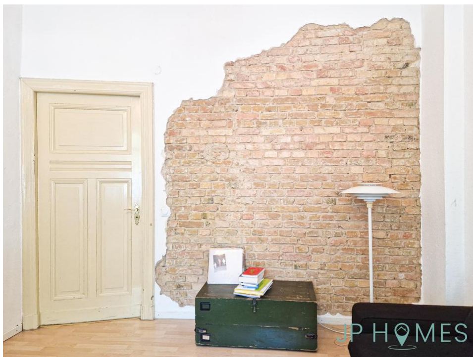
Detailfoto Ziegelwand im Wohnzimmer
