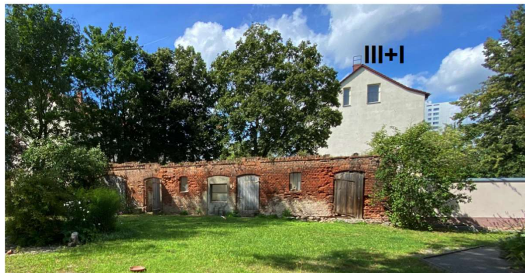
BLICK AUF DEM GRUNDSTÜCK NACH WESTEN RUINE MIT DAHINTER LIEGENDER BEBAUUNG DES NACHBARN (III+D)
