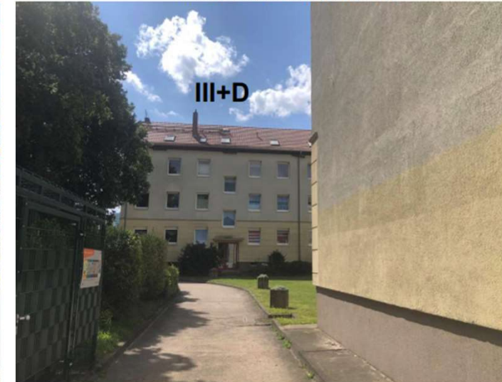
WESTLICHE NACHBARBEBAUUNG IM BLOCK INNENBREICH
